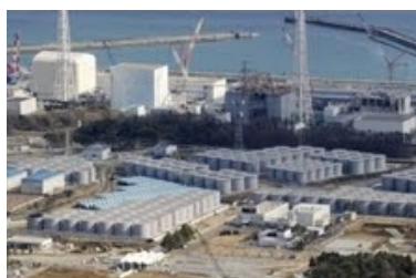
Les 900 cuves contenant au total 300 000m 3 d'eau contaminée. Source : Japan Times
